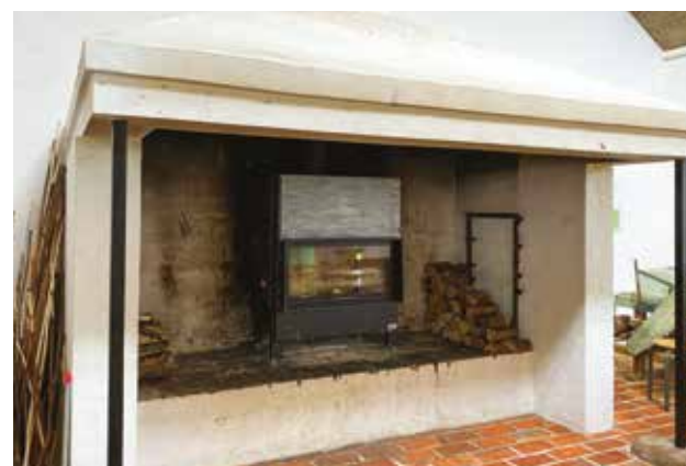
▲ Den nye, lukkede pejs er indsat i den gamle, ineffektive, åbne pejs. Foto: Jakob Kofoed, VHM
